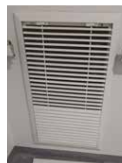
Grille GFA007 sur volet OPTONE avec dispositif PerfONE
