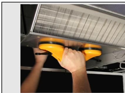
**EXHAUSTO** recommande : L'outil ventouse présenté ici permet de faciliter considérablement la manipulation des échangeurs.
