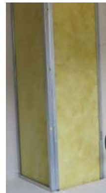
Colocación aislante lana de vidrio semirrígido (velo negro por lado interior imperativamente)
