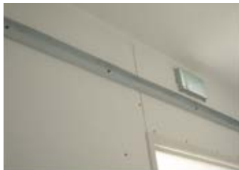
Posicionamiento y fijación de los raíles horizontales a la altura requerida
