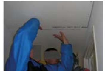
Recorte y fijación placas de yeso para cierre del plenum
