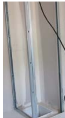
Realización y fijación de la estructura del conducto
