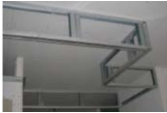
Realización y fijación de la estructura del cierre lateral
