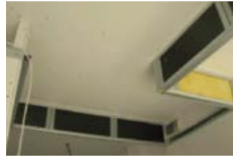
Colocación en falso techo según plano de ejecución
