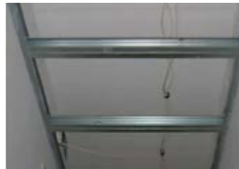
Recorte y colocación de los montantes perpendiculares
