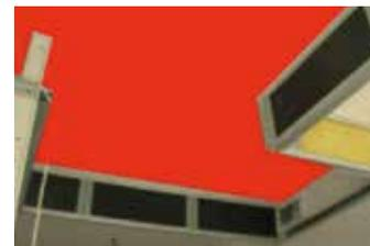
Cas maïsons à étage ou collectif : mise en oeuvre isolant en sous face supérieure du plénum (polystyrène extrudé 25mm, classement feu M1)
