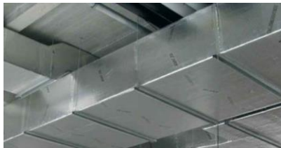
Figure 1 – Réseau de distribution par "conduits isolés"
