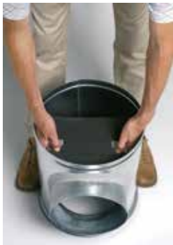
Installation du déflecteur acoustique et aéralique dans le caisson piquage
