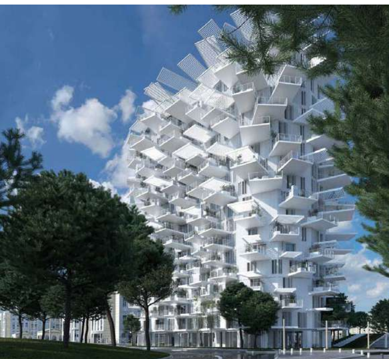
Chantier : l'Arbre Blanc - Montpellier
